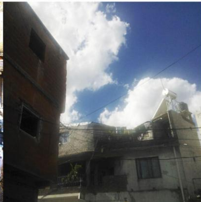
Sistema solar para agua caliente sanitaria
