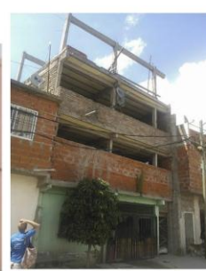
Viviendas de PB+ 3 pisos.
