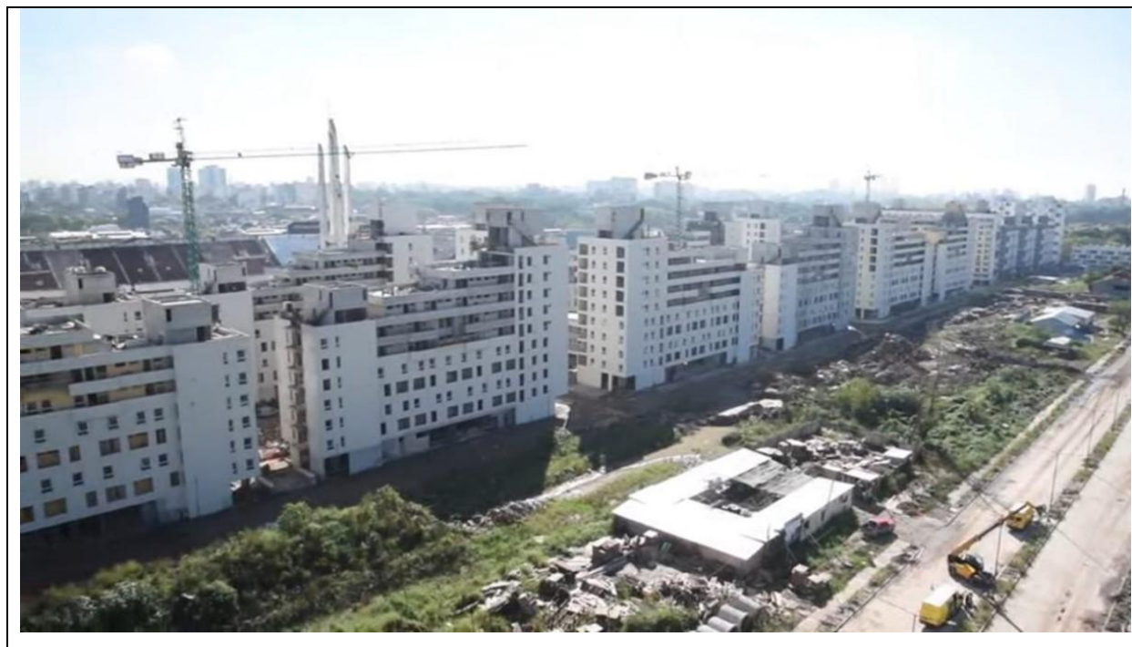
Figura 19 – Vista general de las obras en el mes de mayo de 2018
