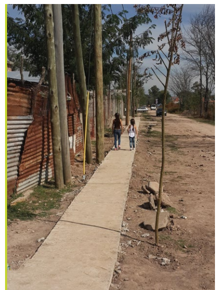
Vista de la ruta de evacuación. Se observan también medidores sobre pilares de madera, altamente peligrosos en estas condiciones (Evacuation route. Dangerous low lying wooden electrical boxes can be seen)
